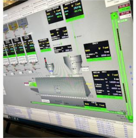
INGENIERÍA DE CAMPO · DIAGNÓSTICO · PUESTA EN MARCHA
